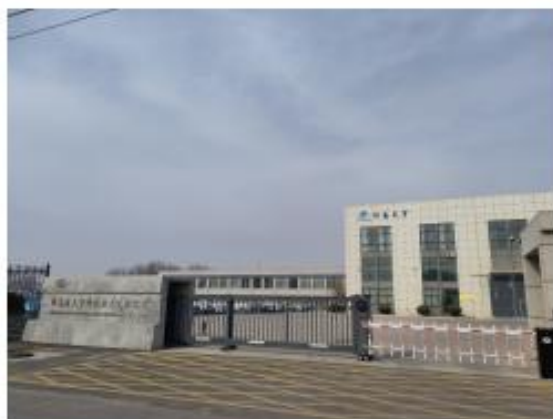
项目厂房现状
